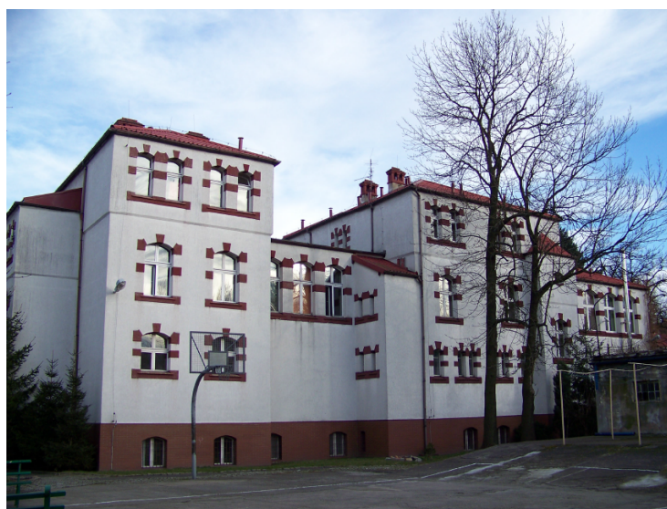
Foto - elewacja zachodnia
