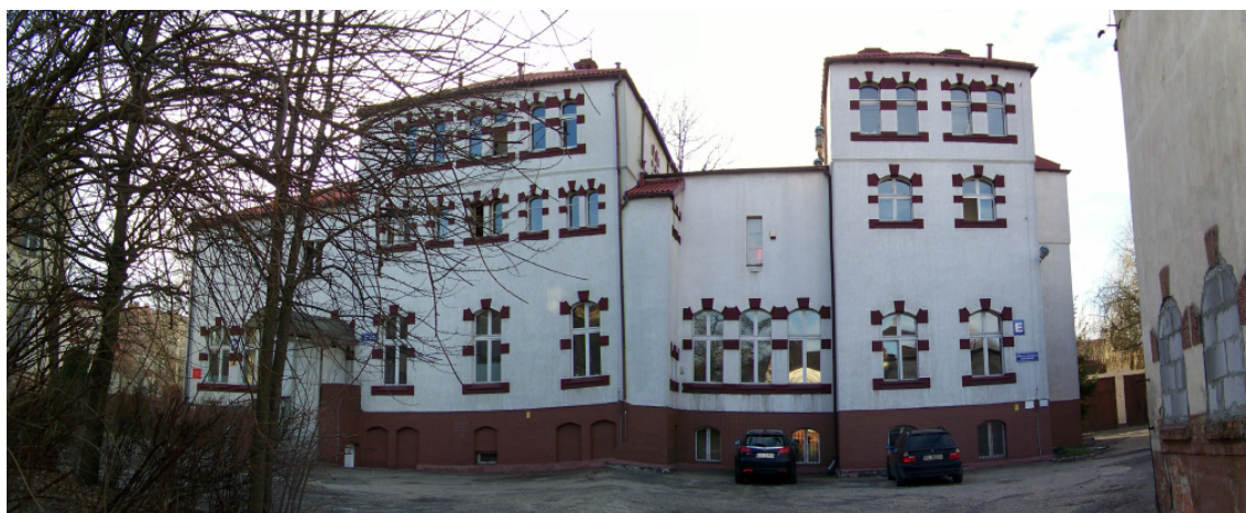
Foto - elewacja wschodnia
