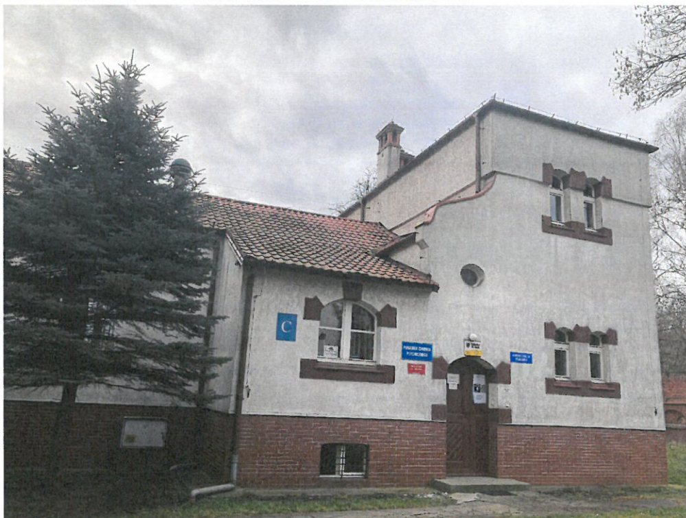
Widok na budynek od strony północnej (wejście główne)
